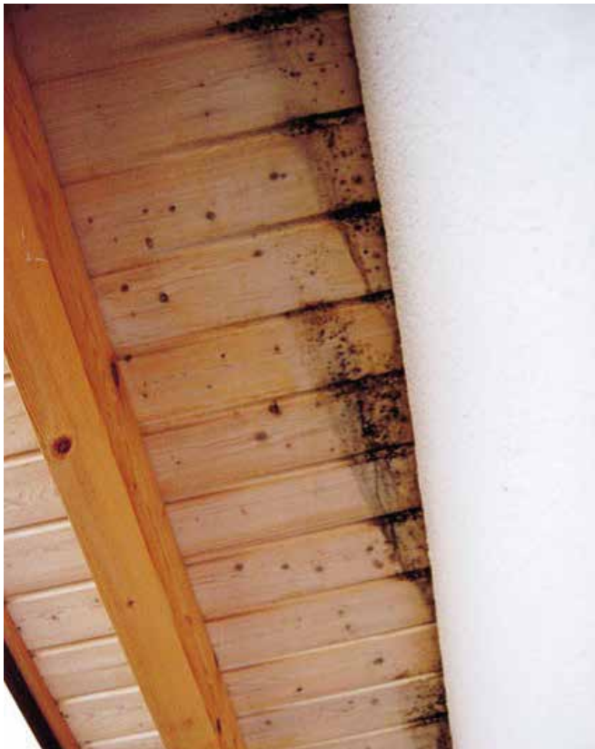
Bild 9: Dachüberstand außen an der Dachwohnung
