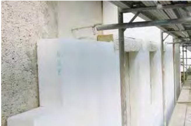
Bild 29: Wärmedämmverbundsystem mit Polystyrol
