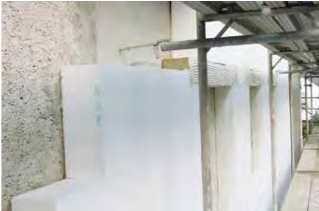
Bild 29: Wärmedämmverbundsystem mit Polystyrol
