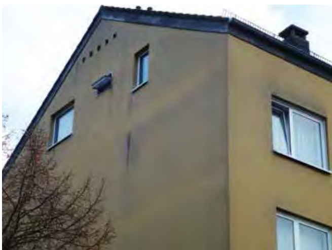
Bild 15–18: Algen gibt es auch auf ungedämmten Fassaden
